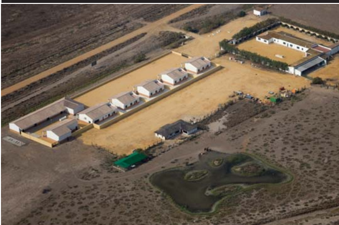
Instalaciones en Huerta Tejada, Doñana
