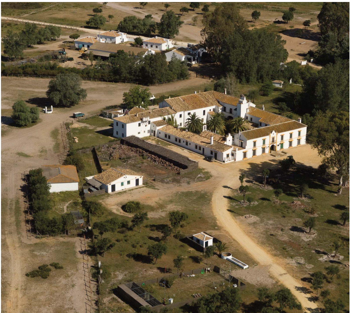
Instalaciones en la Reserva Biológica de Doñana
