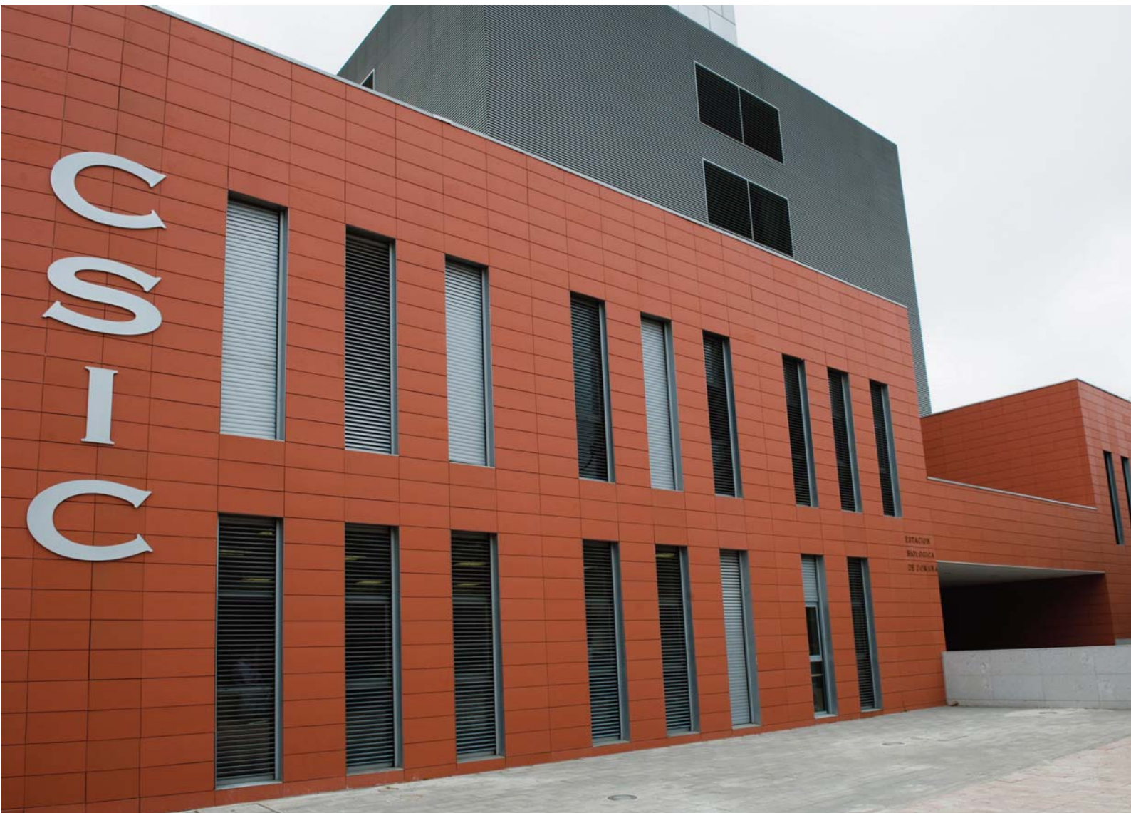
Sede central de la EBD en Sevilla.
